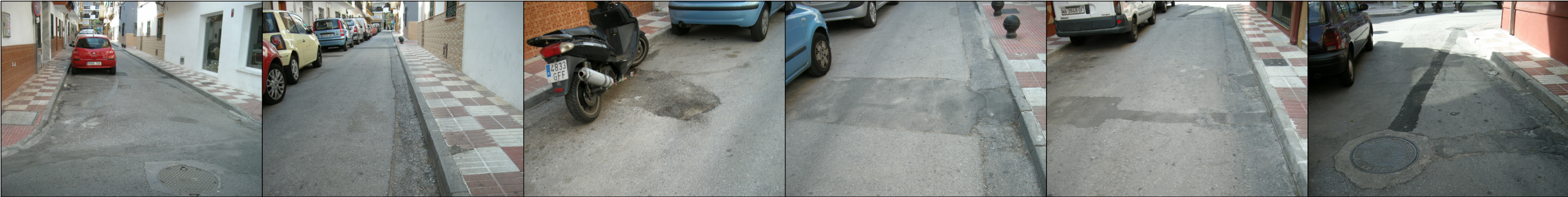
FOTOGRAFÍAS CALLE EXTREMADURA
