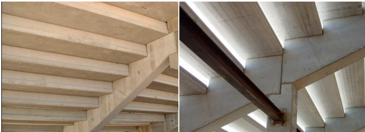
Fotos: vistas de vigas zancas dentadas para el apoyo del graderío.
