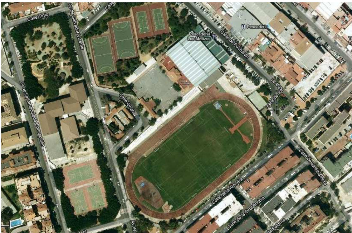
Figura nº 3: Vista aérea del polideportivo, con la pista de atletismo y campo de fútbol en los que se va a intervenir.
