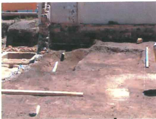
Lam I. Corte 1, inicio de la excavación
