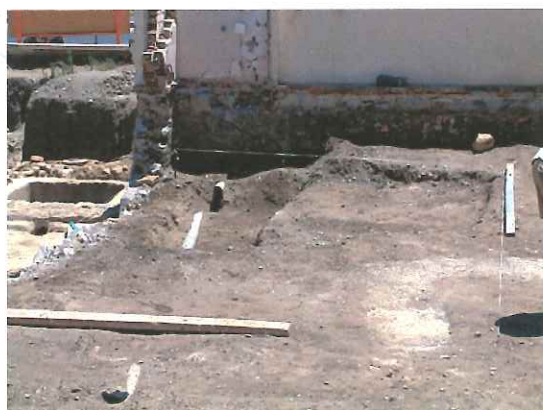
Lam I. Corte 1, inicio de la excavación
