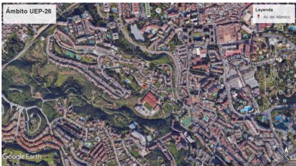
Imagen 2.- Ámbito de la zona afectada por la MECE UEP-26
