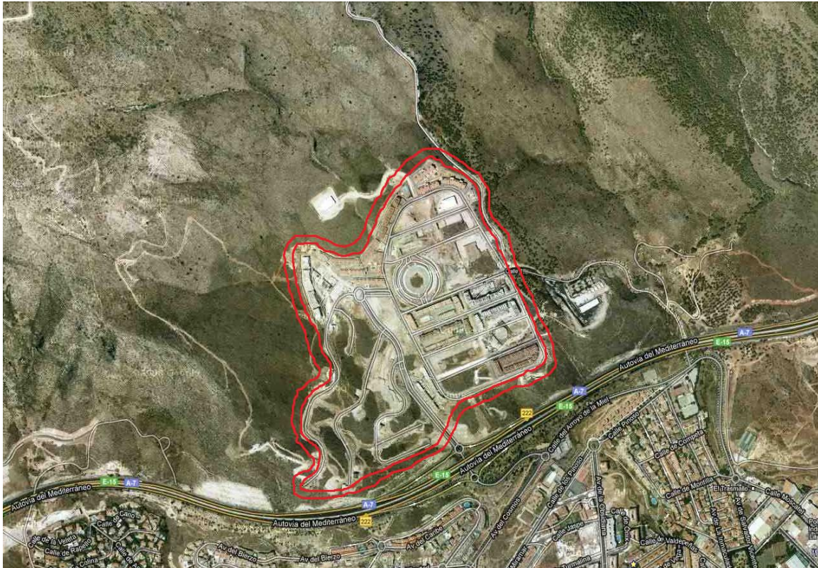
Ejemplo de franja de protección perimetral en urbanización
