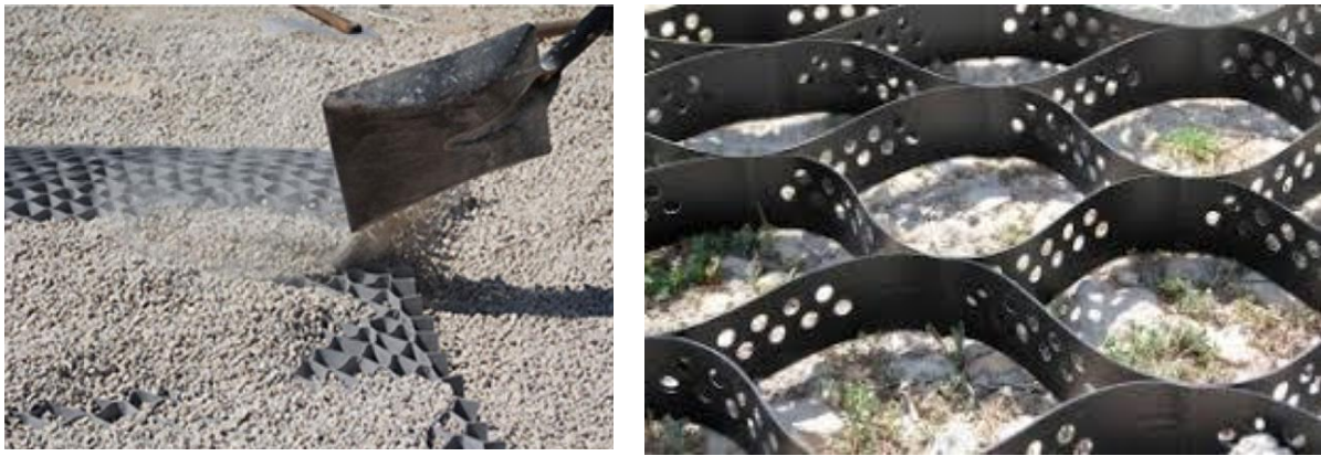
Pavimento tipo Geocell para contención de material granular en aparcamientos
