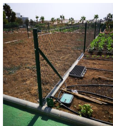
Detalle de bordillo y malla para división de huertos
