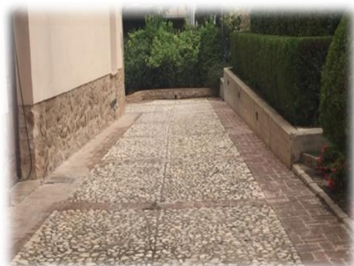
Canto rodado en los pasillos de los decantadores y fuente
