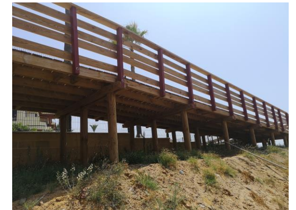
Pasarela de 3m sobre postes para la transición entre el puente y el camino
