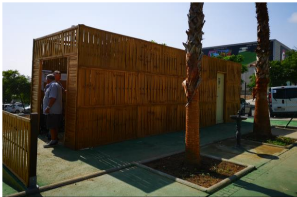
Ejemplo de contenedor para aperos forrado de paneles de madera
