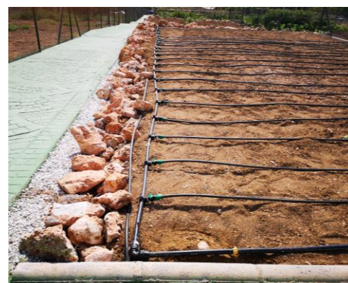
Escollera y acopio de tierra vegetal y red goteo
