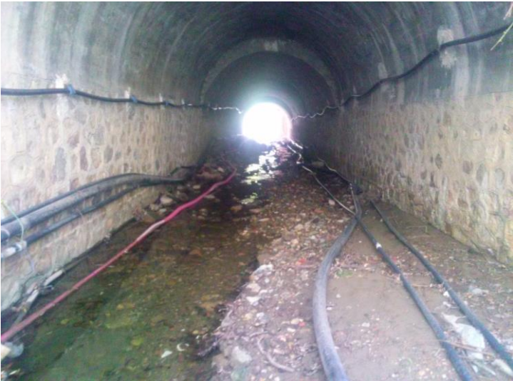
Obra de fábrica para el paso del “Arroyo del Pantano”, que cruza la línea del Ferrocarril
