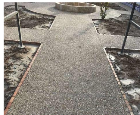
Hormigón desactivado para las zonas estanciales
