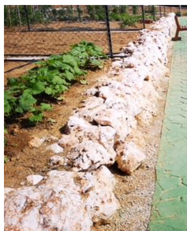
Detalle de escollera careada para creación de bancales
